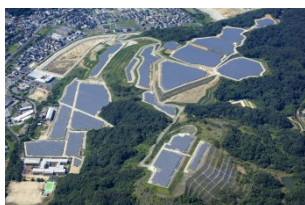
嘉麻第一太陽光発電所
