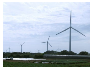
銚子風力発電所
